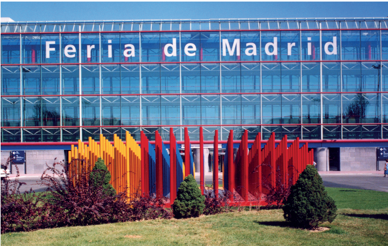
Instalación compensada por CYDESA. Feria de Madrid (Madrid)
