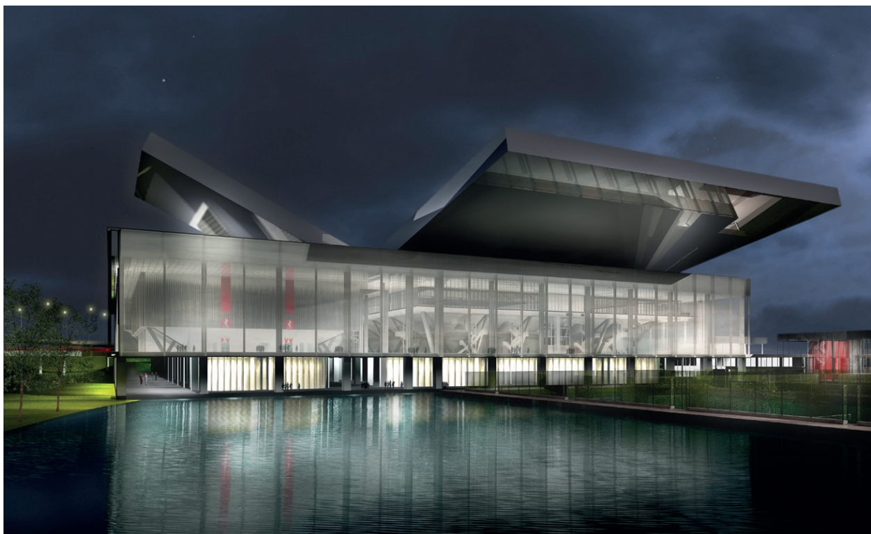
Instalación compensada por CYDESA. Caja Mágica (Madrid)
