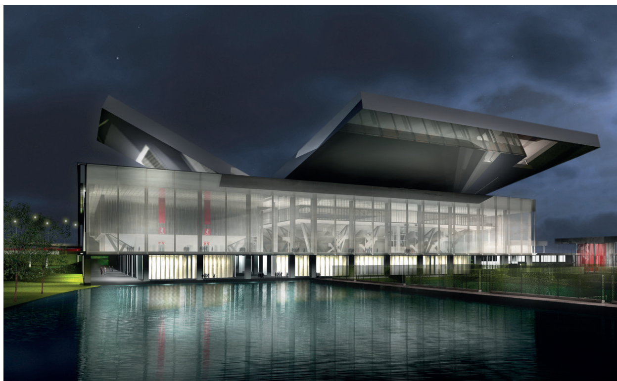
Instalación compensada por CYDESA. Caja Mágica (Madrid)
