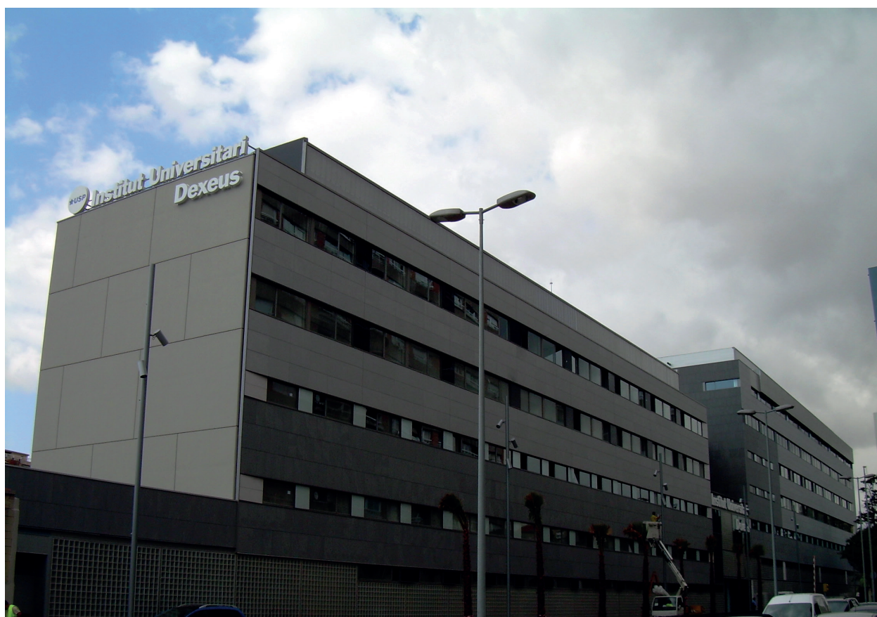
Instalación compensada por CYDESA: 1. Teatros del Canal (Madrid) 2. Institut Universitari Dexeus (Barcelona)
