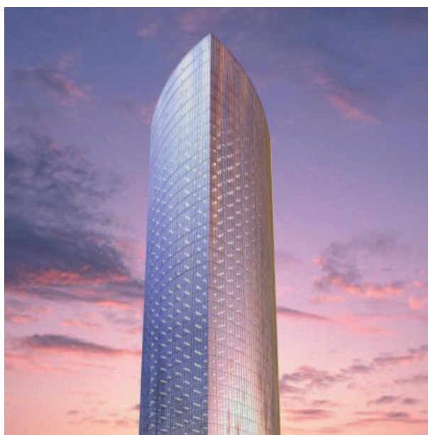
Instalación compensada por CYDESA. Torre Iberdrola (Bilbao)
